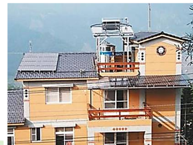
屏東霧台分駐所3kW防災型PV系統
